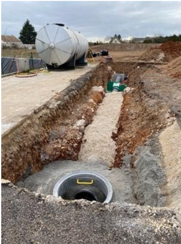
Pose en cours du nouveau réseau, incluant un nouveau séparateur hydrocarbures (en vert)
