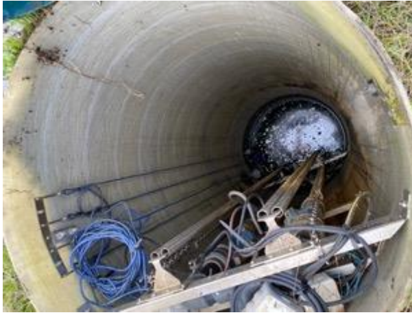
Système de flotteur associé à la pompe afin de réguler le débit de fuite
